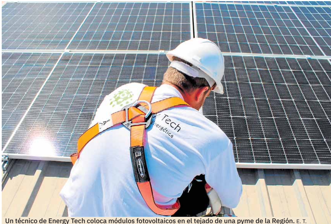
Un técnico de Energy Tech coloca módulos fotovoltaicos en el tejado de una pyme de la Región. E. T.
