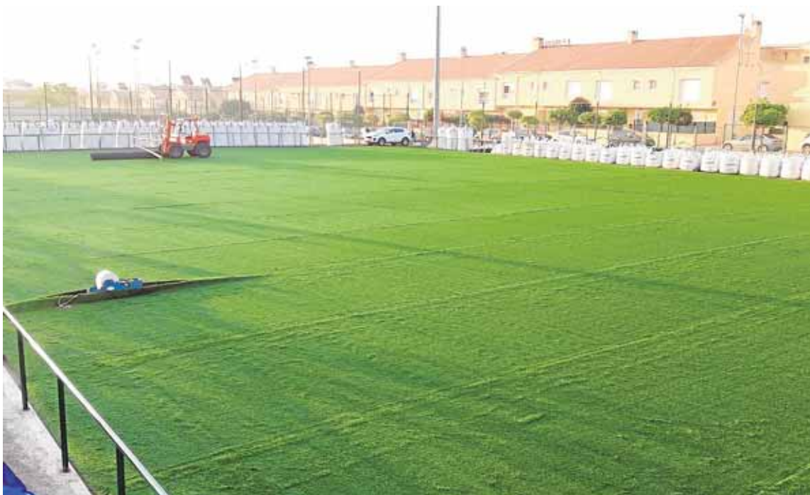
Instalación de césped artificial en Guadalupe.
